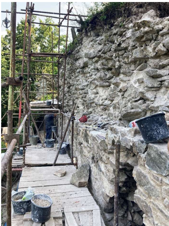
Obr. Sanačný zásah M5/2022: Vľavo: Domurovávanie rozsiahlych plášťových odtrhov Vpravo: Odstraňovanie mohutných stromov vrastených do koruny hradby
